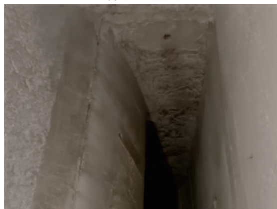
(b) 现场改造情况
